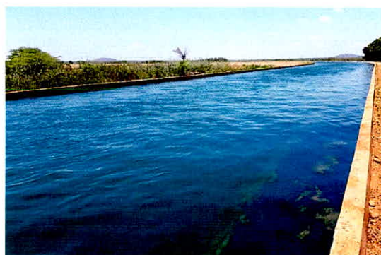
CANAL PRINCIPAL TRAPEZOIDAL TRECHO EB01/EB03 – REVESTIDO
