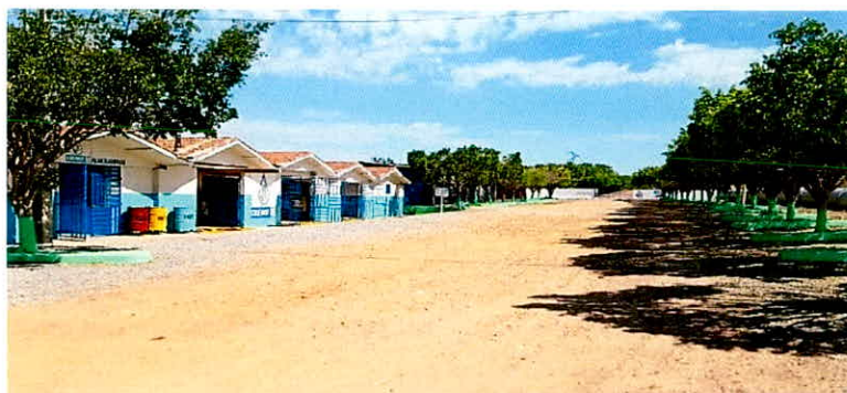
SEDE ADMINISTRATIVA – ESCRITÓRIO, OFICINA ELÉTRICA E MECÂNICA, REFEITÓRIO E OUTROS
