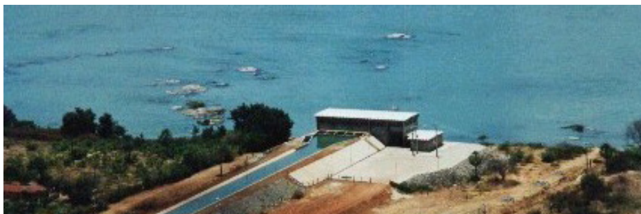
Figura 1 . Estação de bombeamento (EB-01) do Projeto Público de Irrigação Pontal
