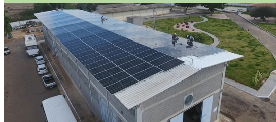
Figura 2 – Instalação das placas de energia solar na sede administrativa do DINC Fonte: DINC, 2021.
