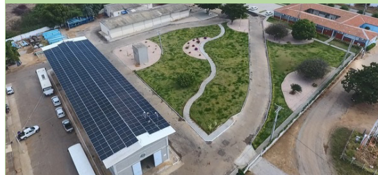
Figura 1 – Planta de energia solar na sede administrativa do DINC Fonte: DINC, 2021.
