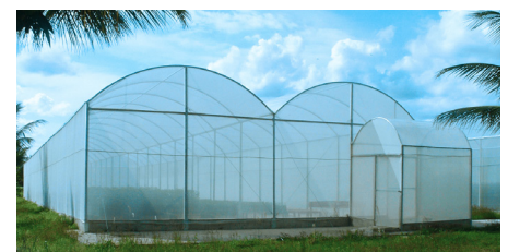
Figura 6: Modelo teto em arco com formato raso em parábola invertida, com flecha variando entre 0,9 e 1,1 m Fonte: EMBRAPA, 2005.
