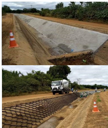
Geocélulas utilizadas na recuperação de placas de concreto
