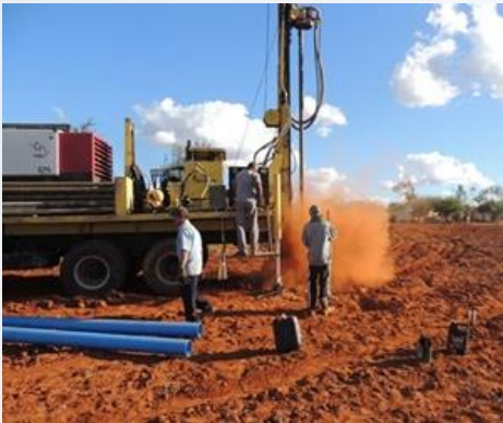
Perfuração de poços
