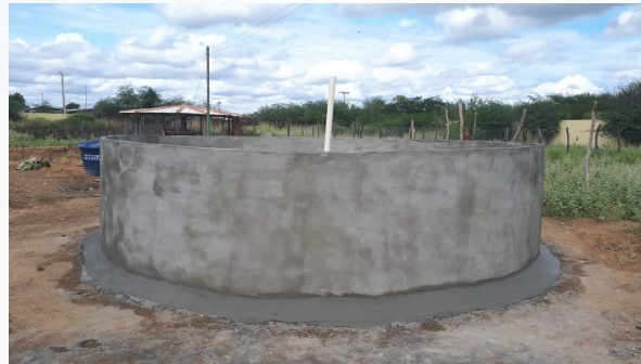
Tanque de ferro cimento
