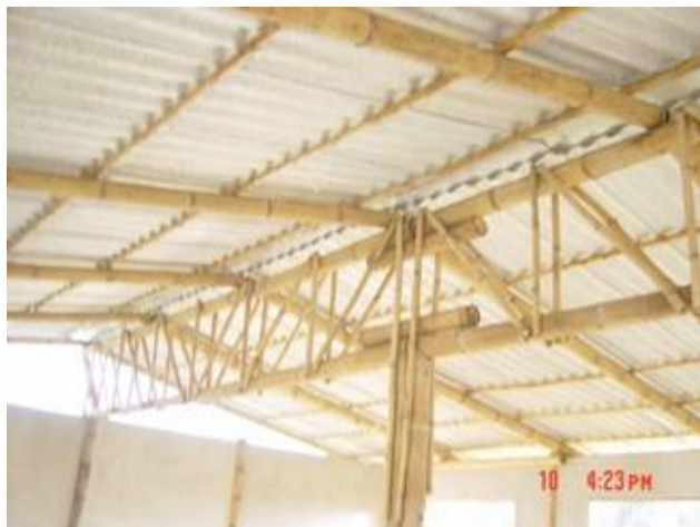
ESTRUTURA PARA COBERTURA
