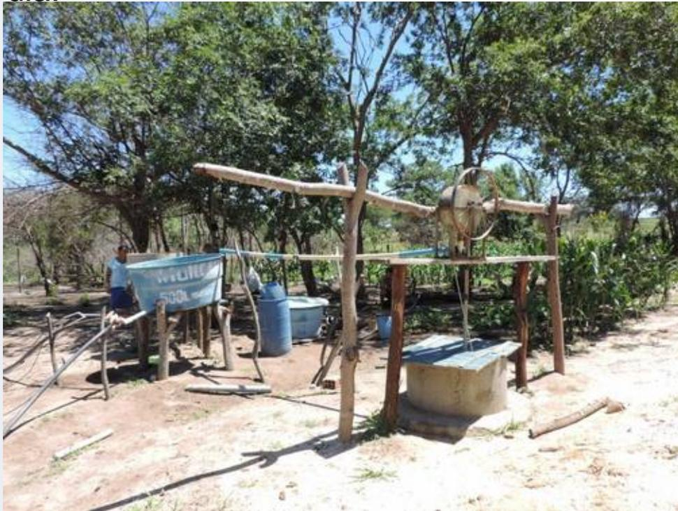
Sistema de bombeamento é por corda, composto por 01 motobomba a gasolina, com vazão de 1,38 litros/segundo, e conta com 02 caixas d'água de 500 litros cada.
