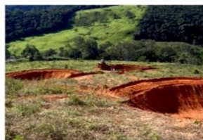
Fig. 1: Barraginhas em construção
