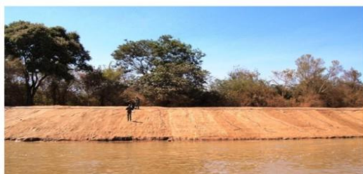
Fig. 1 – Taludamento e cobertura com biomanta de fibra de côco (fonte: AR/GSA/UCF, 2013)
