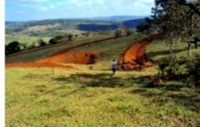
Fig. 3: Terraceamento
