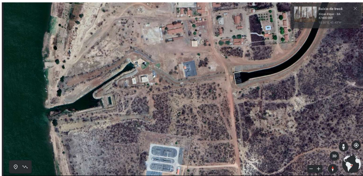
Figura 2 – Vista aérea do canal de canal de aproximação
