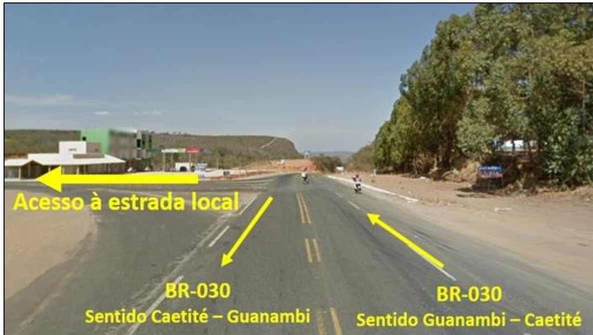
Figura 1-10 – Acesso à estrada local - Via Guanambi.
