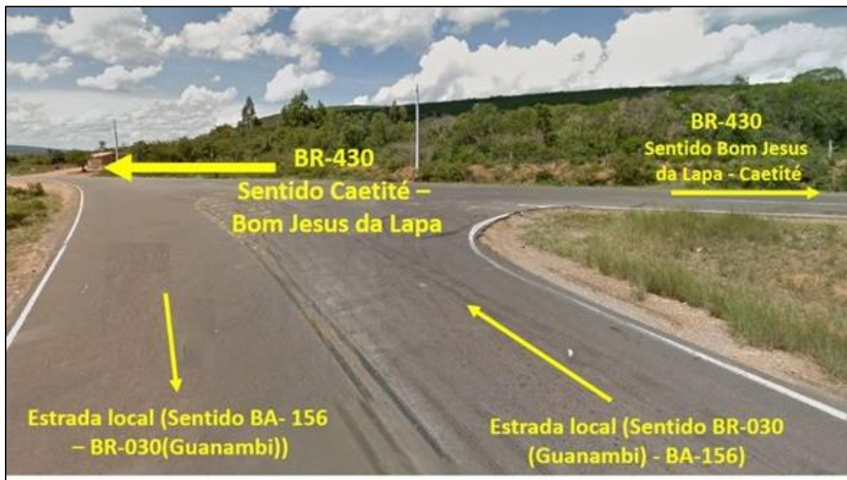
Figura 1-11- Acesso à BR-430 em cruzamento com estrada local - Via Guanambi.
