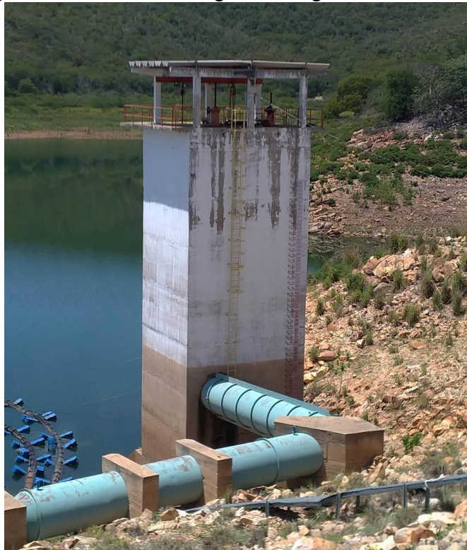
Figura 21 – Tomada d'água barragem Bico da Pedra
