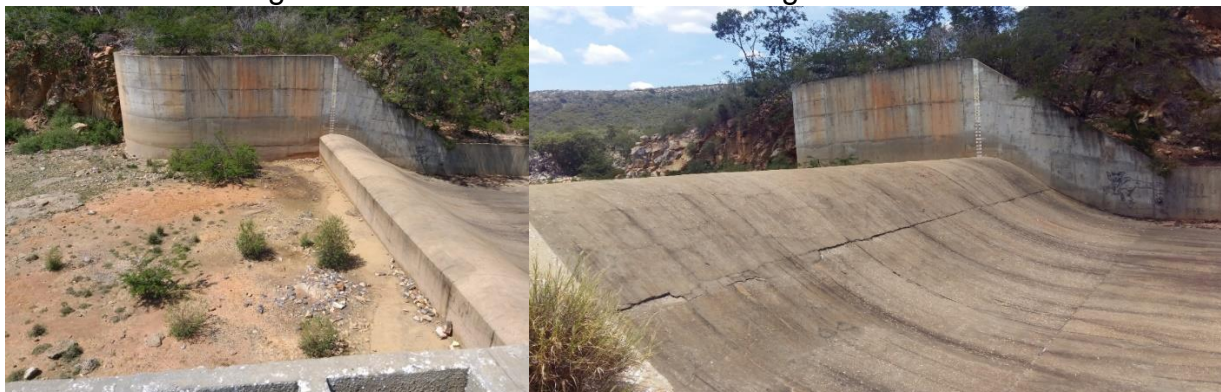
Figura 9 – Vistas do Vertedouro Barragem Bico da Pedra
