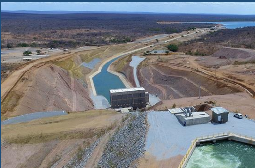
Foto: Estação de Captação do Rio São Francisco – Eixo Leste
