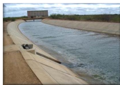
Canal de Perímetro de Irrigação Pontal
