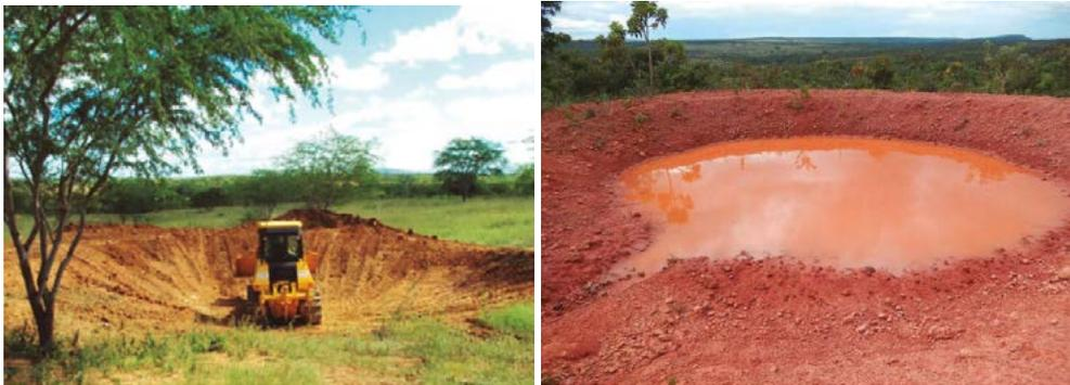
*Figura 61 A e B. Obra de construção de bacias para captação (barraginhas) de água de chuvas e de sedimentos*
