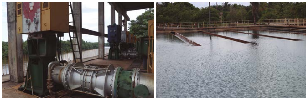
Figura 5. A e B. Sistema de Abastecimento de Água de São Luís - Italuís
