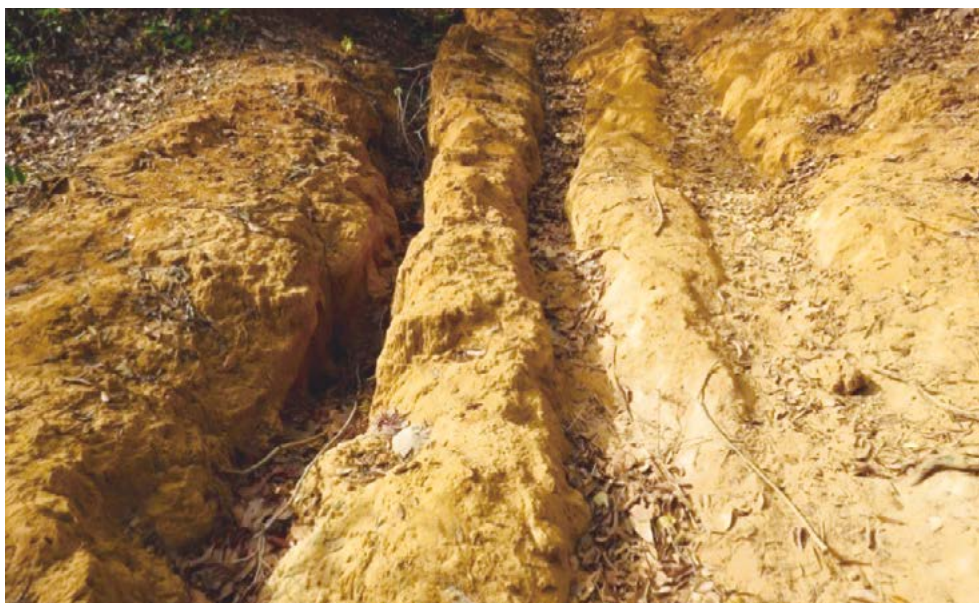
Figura 48. Erosão próxima a nascente de rio
