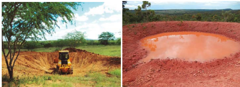
Figura 61 A e B. Obra de construção de bacias para captação (barraginhas) de água das chuvas e de sedimentos
