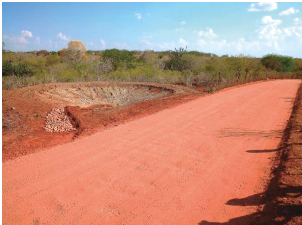
Figura 62. Adequação de estrada rural associada a bacia de captação de enxurrada
