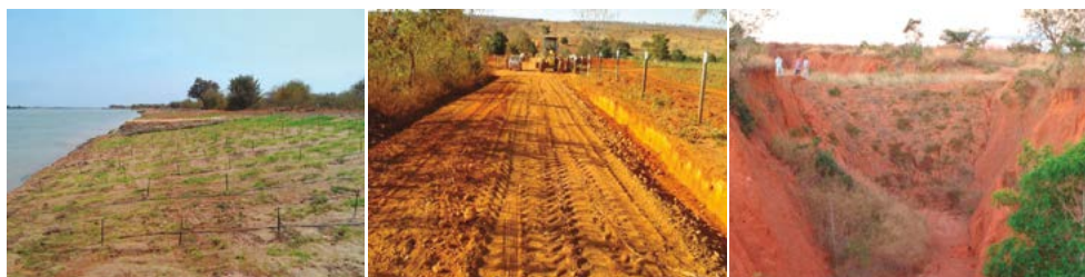
Figura 71 A a C. Contenção de margens de trecho do rio São Francisco (esquerda), adequação de estradas (centro), contenção de voçoroca na bacia do rio Parnaíba (direita)
