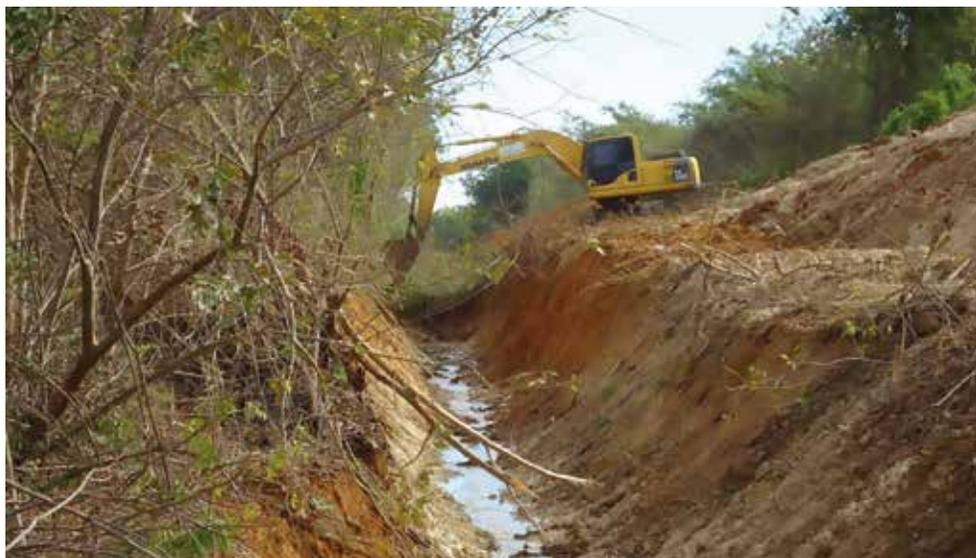
**FIGURA 19 – EXECUÇÃO DOS SERVIÇOS DE CONSTRUÇÃO DOS DRENOS NO PROJETO FORMOSO**
