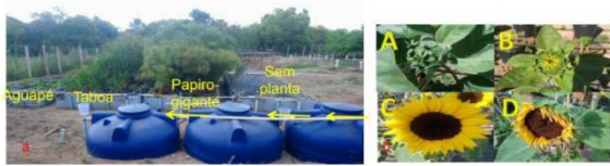
Figura 1. Leitos cultivados com macrofitas e três tanques sépticos em série (a) e estádios de desenvolvimento da inflorescência do girassol nas fases R1- A; R4- B; R5.1- C; e R6- D (b)
