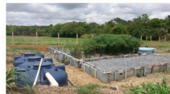
Figura 3. Vista da estação de tratamento de esgotos da Fazenda Água Limpa. TS e SZR.
