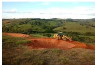
Fig. 2 – Construção de Barraginha - Município de Itaguara/ Sub-bacia Córrego Catuá (fonte: Codevasf, 2017).
