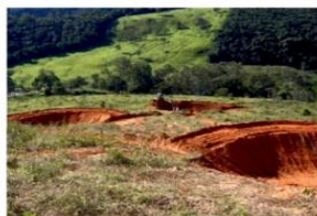
Fig. 1: Barraginhas em construção
