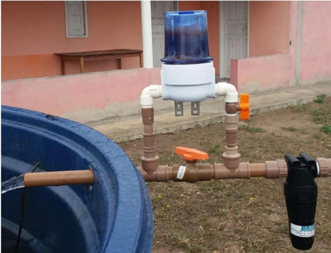
Figura 15 – Instalação padrão: catalisador Eco Íon e dosador de cloro em pastilha.
