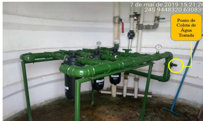
Figura 22 – Ponto de coleta de água tratada
