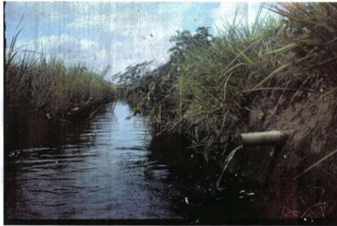
Figura 1 – Drenagem subterrânea e coletora no Vale do Curu – CE
