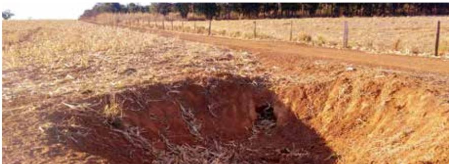
Figura 24 - Estrada dentro de propriedade rural com barraginha e “palhada”
