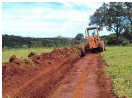
Figura 21 - Construção da curva em nível (terraço)
