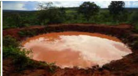
Figura 15 - Bacia de captação de água de enxurrada
