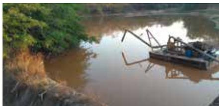
Figura 17 - Barragem sendo desassoreada
