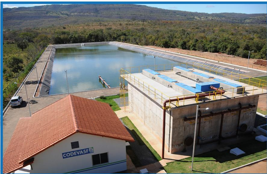
Estação de Tratamento de Esgoto – Digestor Anaeróbico de Fluxo Ascendente + Lagoa de Polimento – Município de Buenópolis – MG. Fonte: Codevasf, 2014.
