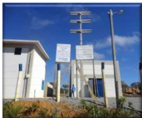
Adutora do Algodão/BA - EEAT
