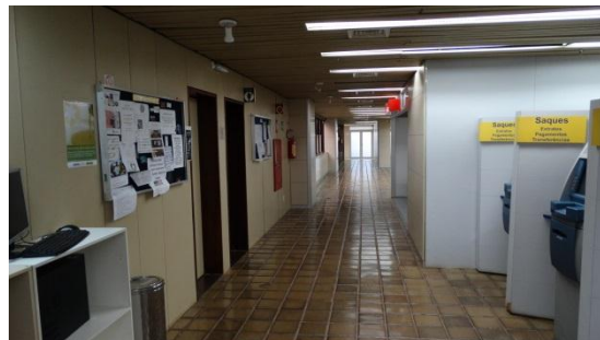
Foto 28: Corredor de circulação do 1º andar sem piso tátil direcional e com piso trepidante; Brasília-DF, 22/07/2015.
