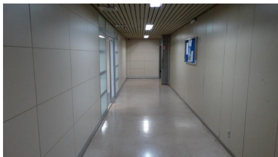
Foto 31: Corredor de circulação do 2º andar sem
