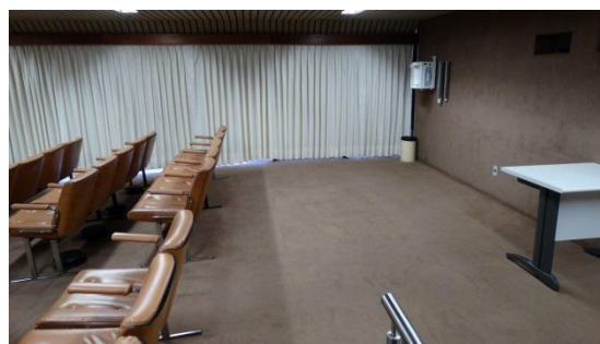
Foto 64: Acesso e área de circulação do auditório com bebedouro instalado acima da altura correta (os registros de água estão a 153cm de altura do piso); Brasília-DF, 22/07/2015.
