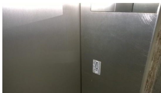
Foto 21: Sinalização do andar em braile afixada no local incorreto (lateral da entrada/saída do elevador); Brasília-DF, 22/07/2015.
