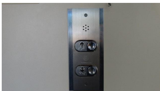
Foto 20: Botoeira do elevador com indicação em braile; Brasília-DF, 22/07/2015.
