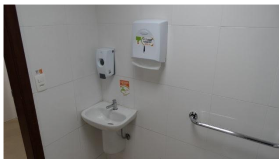
Foto 59: Lavatório do banheiro acessível do 3º
