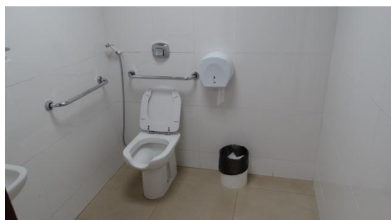
Foto 55: Interior do banheiro acessível do 3º andar: barras de apoio com diâmetro de 2,5cm, comprimento de 60cm e altura em relação ao piso de 90cm (medidos do eixo de fixação); a distância medida entre o eixo da bacia e a face da barra lateral ao vaso é de 42cm; a distância medida entre a borda frontal da bacia e a projeção do 1º ponto de fixação da barra lateral é de 20cm; a distância medida entre o 2º ponto de fixação da barra lateral e a parede do fundo é de 19cm; papeleira instalada a 95cm do piso e na parede errada; ausência de cabide, de porta-objetos e de puxador horizontal do tipo gaveta junto às dobradiças no lado interior da porta; Brasília-DF, 22/07/2015.
