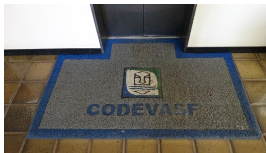
Foto 17: Capacho dos elevadores do 1º andar não embutido no piso; Brasília-DF, 22/07/2015.
