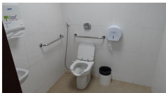
Foto 53: Interior do banheiro acessível do 1º andar: barras de apoio com diâmetro de 2,5cm, comprimento de 60cm e altura em relação ao piso de 90cm (medidos do eixo de fixação); a distância medida entre o eixo da bacia e a face da barra lateral ao vaso é de 42cm; a distância medida entre a borda frontal da bacia e a projeção do 1º ponto de fixação da barra lateral é de 20cm; a distância medida entre o 2º ponto de fixação da barra lateral e a parede do fundo é de 19cm; papeleira instalada a 95cm do piso e na parede errada; ausência de cabide, de porta-objetos e de puxador horizontal do tipo gaveta junto às dobradiças no lado interior da porta; Brasília-DF, 22/07/2015.
