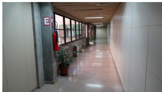
Foto 32: Corredor de circulação do 2º andar sem
