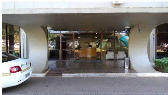
Foto 05: Entrada do prédio da Codevasf com piso trepidante; Brasília-DF, 22/07/2015.
