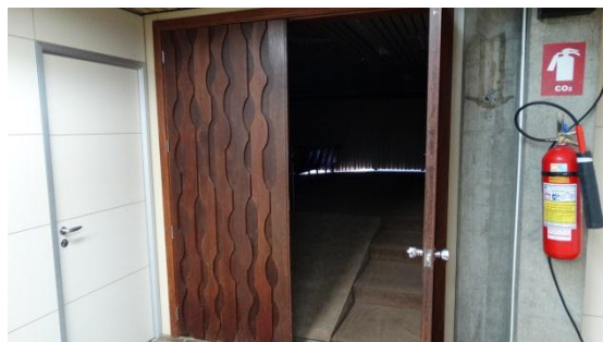
Foto 61: Porta de entrada do auditório; Brasília-DF, 22/07/2015.
