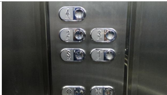
Foto 24: Botões do elevador com indicação em braile; Brasília-DF, 22/07/2015.
