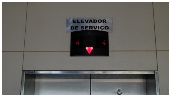
Foto 18: Pannel do elevador com indicação visual “sobe/desce”, indicação de andar e aviso sonoro; Brasília-DF, 22/07/2015.
