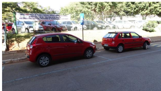
Foto 02: Duas vagas para PNE sem demarcação de espaço adicional para circulação e sem rebaixamento da calçada; Brasília-DF, 22/07/2015.
