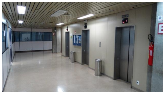
Foto 37: Hall dos elevadores do 4º andar sem sinalização tátil de alerta no piso e sem piso tátil direcional; Brasília-DF, 22/07/2015.
