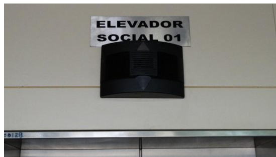
Foto 19: Pannel do elevador com indicação visual “sobe/desce”, indicação de andar e aviso sonoro; Brasília-DF, 22/07/2015.
