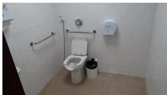
Foto 54: Interior do banheiro acessível do 2º andar: barras de apoio com diâmetro de 2,5cm, comprimento de 60cm e altura em relação ao piso de 90cm (medidos do eixo de fixação); a distância medida entre o eixo da bacia e a face da barra lateral ao vaso é de 42cm; a distância medida entre a borda frontal da bacia e a projeção do 1º ponto de fixação da barra lateral é de 20cm; a distância medida entre o 2º ponto de fixação da barra lateral e a parede do fundo é de 19cm; papeleira instalada a 95cm do piso e na parede errada; ausência de cabide, de porta-objetos e de puxador horizontal do tipo gaveta junto às dobradiças no lado interior da porta; Brasília-DF, 22/07/2015.
