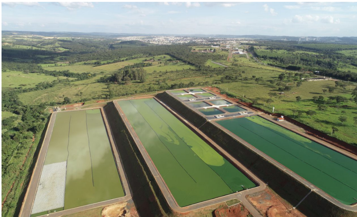
Figura 1 - Imagem aérea das lagoas anaeróbias, facultativa e de polimento da nova ETE de Arcos (MG)
