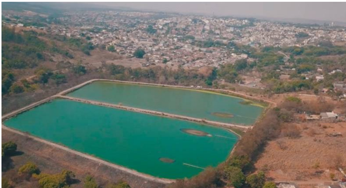
Figura 2 - Antiga ETE do município de Arcos (MG)
