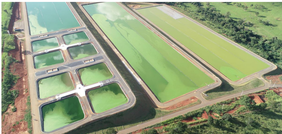
Imagem aérea das lagoas anaeróbias, facultativa e de polimento da nova ETE de Arcos (MG)
