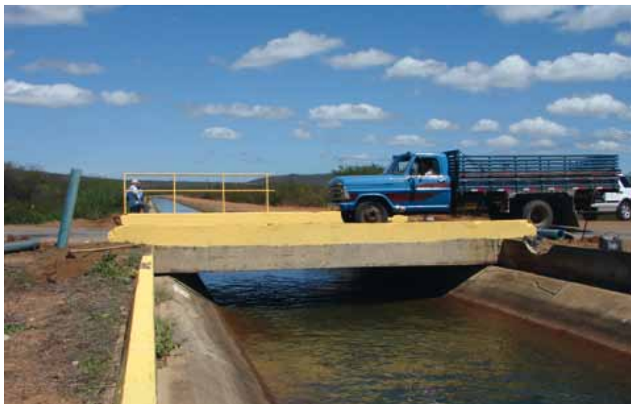
Empreendimento irá facilitar escoamento da produção
