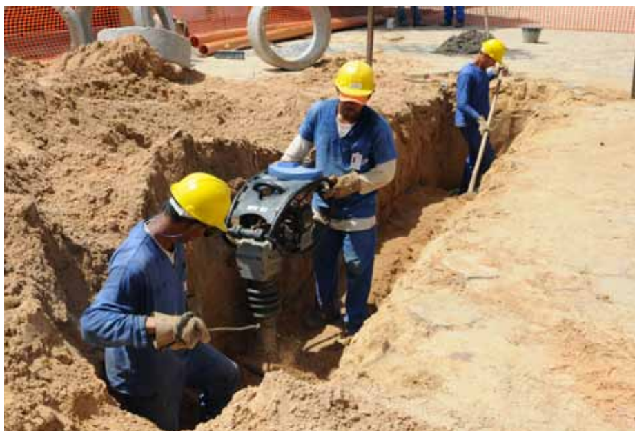
Obras de esgotamento sanitário: mais qualidade de vida para população
