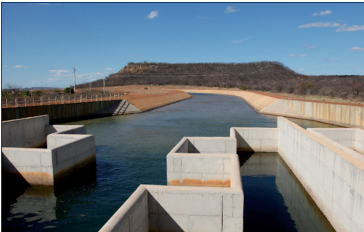
Canal principal do Projeto de Irrigação do Baixio de Irecê na Bahia
