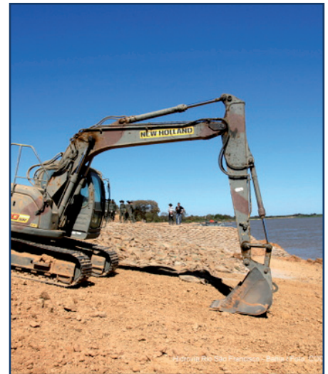
Obras da hidrovía na Bahia
