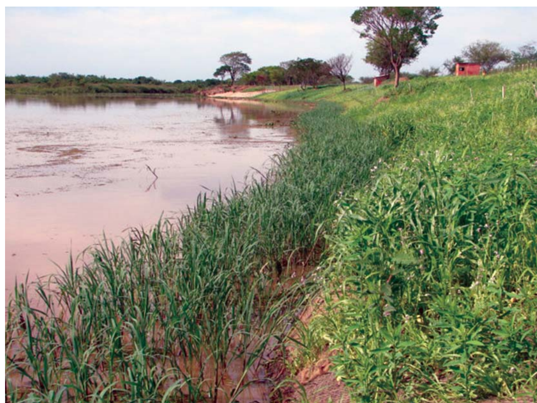
Contenção de margens: a primeira foto mostra o processo erosivo das margens fragilizadas e as duas últimas mostram o resultado da intervenção
