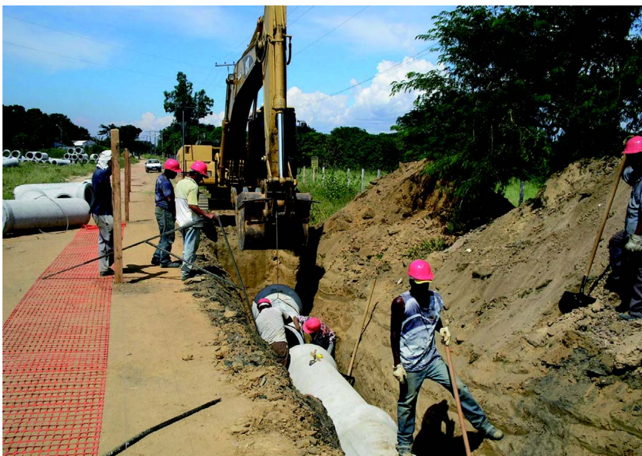
Implantação de rede de esgoto
